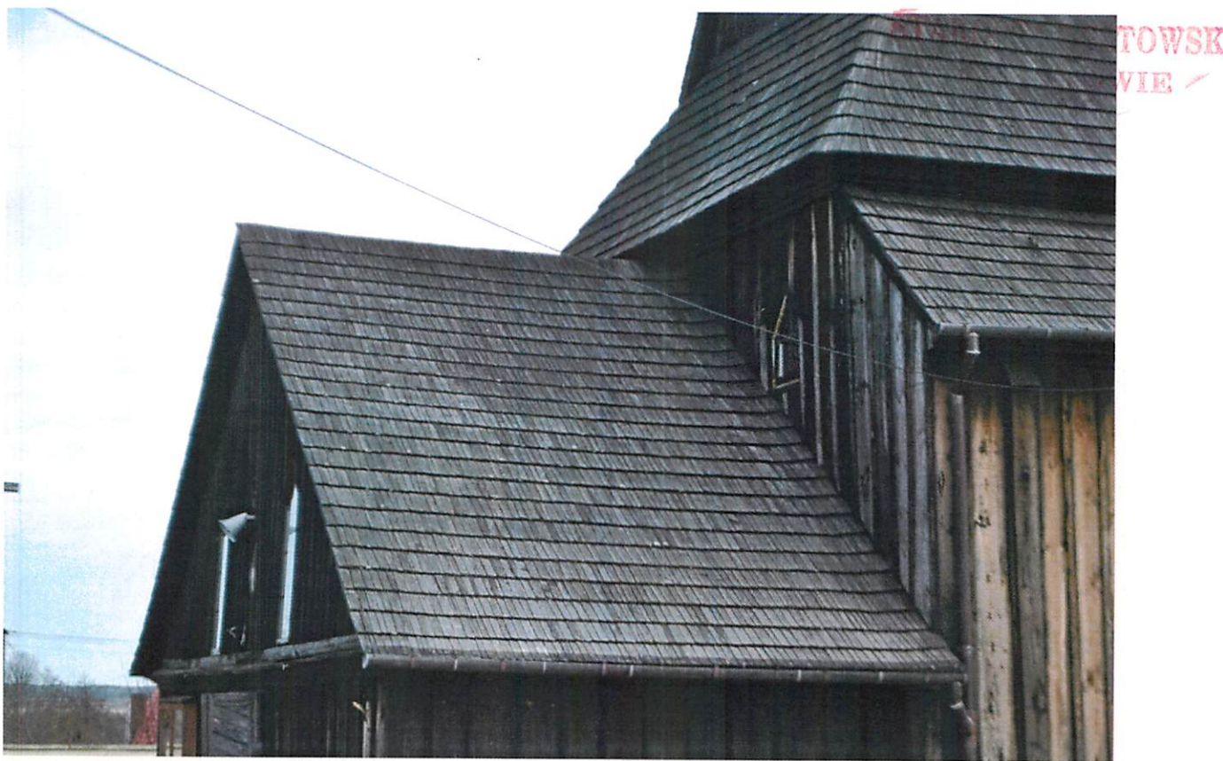
Fot. Nr 8. Widok pokrycia gontowego połaci dachowej kruchty głównej przewidzianego do wymiany ze względu na przecieki i rozwarstwienie, dodatkowo planowana wymiana konstrukcji zbutwiałych krokwi
