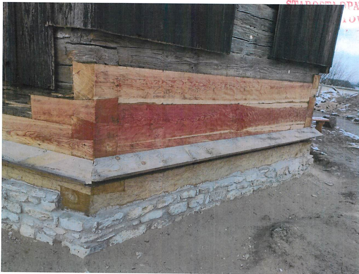
Fot. Nr 4 Zabytkowy drewniany kościół w Glinianach- Szczegółowy widok wyremontowanych belek podwalinowych i zrębowych, strona wschodnia- rok 2020
