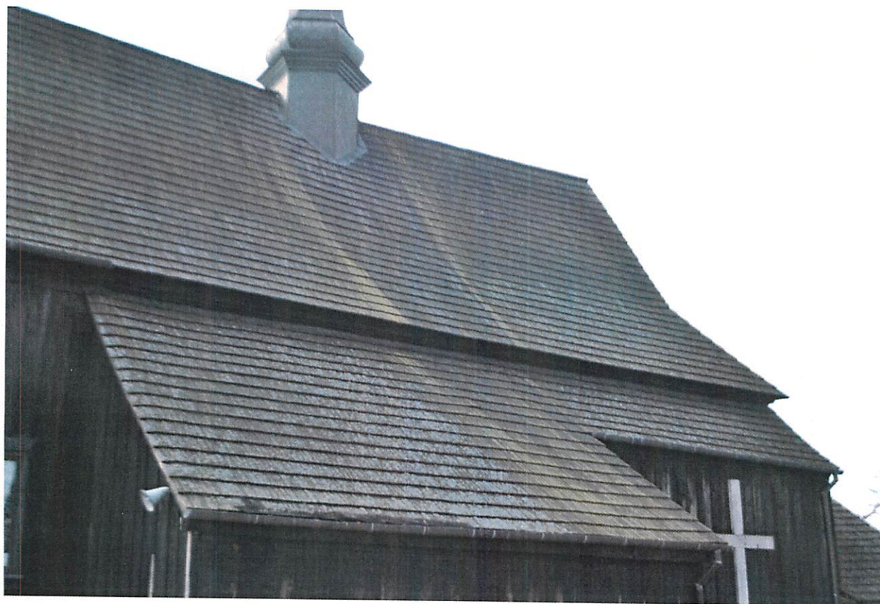
Fot. Nr 7. Widok pokrycia gontowego połaci dachowej bocznego aneksu nawy pokryty gontem wykazującym szereg przecieków i rozwarstwień pokrycia.
