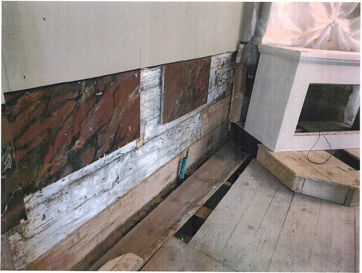
Fot. Nr 10. Widok zbutwiałego deskowania podłogi oraz legarów podłogowych ułożonych na ziemi
