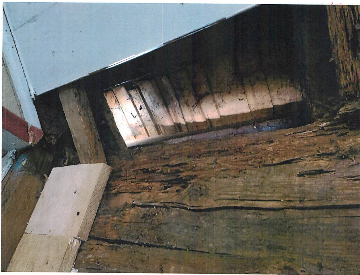
Fot. Nr 6. Widok zbutwiałych belek konstrukcji zrębowej kruchty głównej
