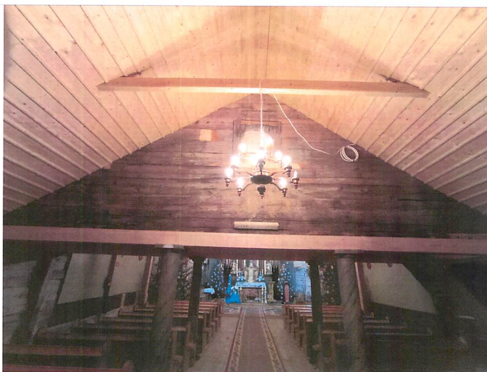
Fot nr 10. Kruchta. Ściana szczytowa kościoła. Oryginalna powierzchnia belek oraz rozeta.
